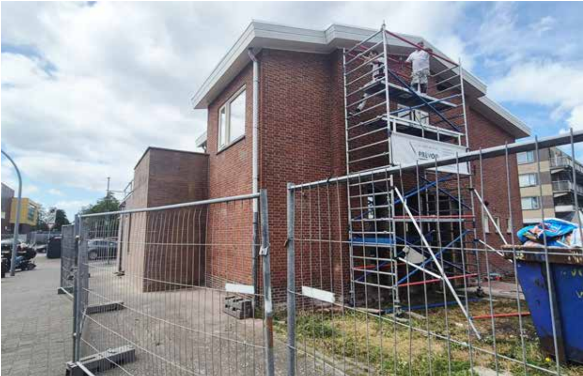
Een aantal bewoners heeft al gezien hoe het gebouw opknapt. In september kunnen we er in. Er is een feestelijke opening op woensdag 10 september tussen 14:00 en 14:30. Ook worden tot 16:00 een aantal activiteiten voor en achter het gebouw georganiseerd. Samen met de winkeliers gaan we dit organiseren.
